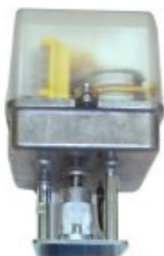
Disponibile per alimentazione a 24 V e 230 V MB30B è controllato da un segnale increase/decrease a 3 punti. Il campo di rotazione dell'attuatore è impostato in fabbrica a 90° per adattarsi con TRV-S. Un indicatore fra l'attuatore e la valvola segnala la posizione della valvola.
